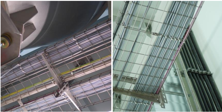
Waagrechte Montage mit Wand- und Deckenauslegern
