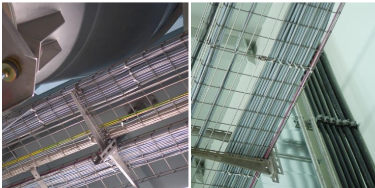
Waagrechte Montage mit Wand- und Deckenauslegern
