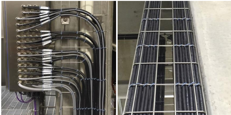
Gittertrassen in Edelstahl V2A bzw. V4A
