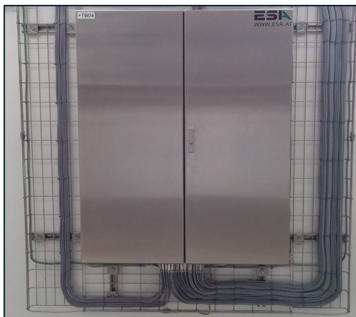
Steuerungsverteiler mit ET200SP Baugruppen:
