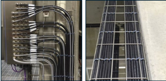
OPTION: Gittertrassen in Edelstahl V2A bzw. V4A
