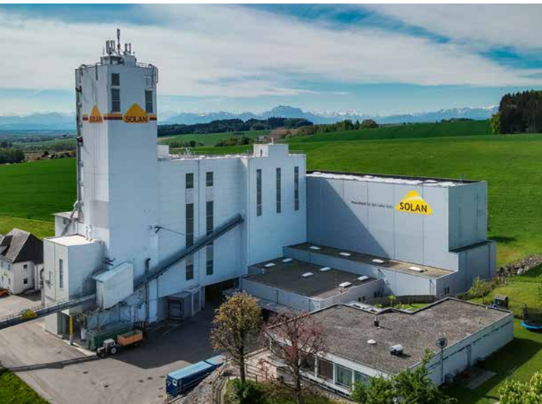
Solan-Kraftfutterwerk in Bachmanning/Oberösterreich
